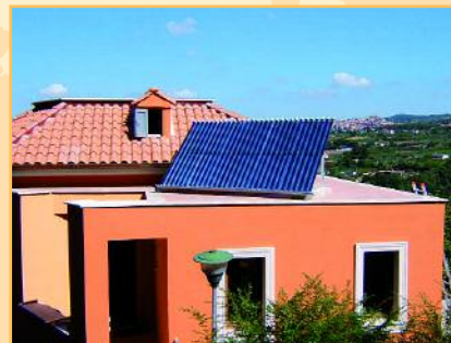
Aufgeständerte Lösung von 6 TUBO-Modulen, Italien
