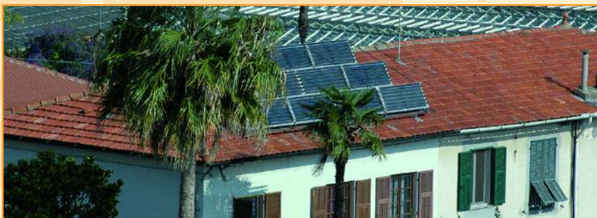
Waagrecht aufgeständerte TUBO-Kollektoren, Südeuropa
