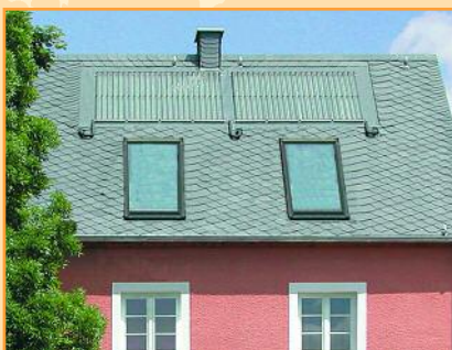
Kaum sichtbare indachmontierte TUBO-Module, Deutschland
